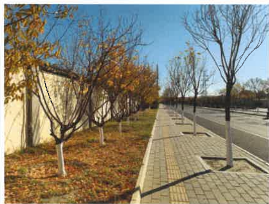
透水铺装和绿化（2022年10月）
