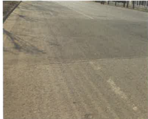
透水铺装和绿化（2021年4月）
