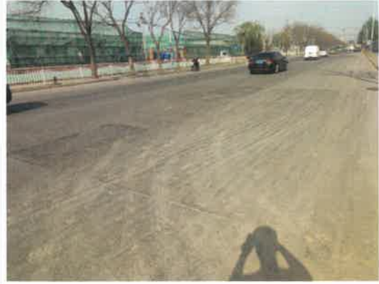
透水铺装和绿化（2021年4月）
