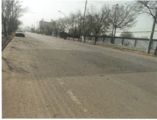
透水铺装和绿化（2021年4月）
