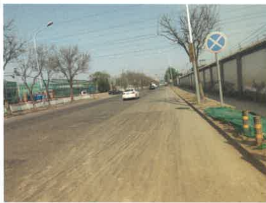
透水铺装和绿化（2021年4月）
